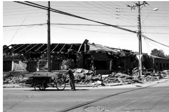
Efectos del terremoto del 27 de febrero de 2010 en Talca. Fotografía: Alexis Martínez.
